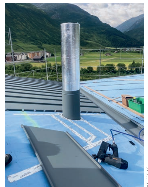
Einfassungen wurden vor Ort ins Prefalz Blech eingefalzt.
