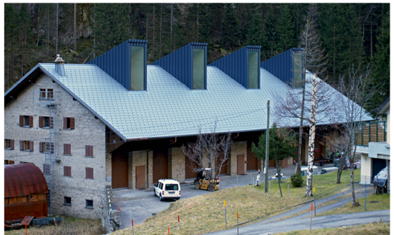
... und nach dem gelungenen Umbau
