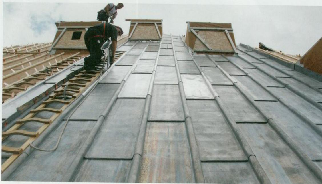
Die speziell angefertigten Dachleitern passen exakt zwischen die Wulste und bieten sicheren Halt. Selbstverständlich sind bei der 52° Dachneigung alle Mitarbeiter angesieilt
