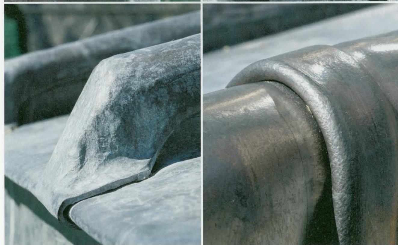
Solche Details bekommt man nur selten zu sehen, weil sie zu weit entfernt sind. Außerdem werden Bleidächer nicht so häufig gebaut: Die Abschlüsse der Wulste mit Übergang zu den Seitenwänden der Lukarnen sowie an den Dachkanten sind manuell angeformt. Die nahtlosen Kanten bieten dem Sturm keine Angriffsflächen und dem Regen keine Schlupflöcher. Die solide Handarbeit wirkt wie für die Ewigkeit gebaut, und tatsächlich können Bleidächer mehrere Jahrhunderte überdauern
