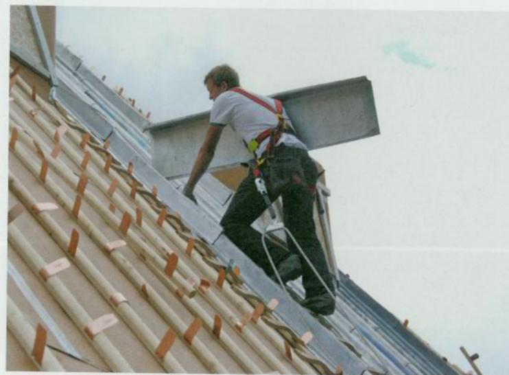
Auf der Unterkonstruktion sind die Holzwalste mit Haften aufgebracht. Die Bleipaneele sind zugeschnitten und abgekantet. Jedes Paneel wiegt etwa 40 kg
